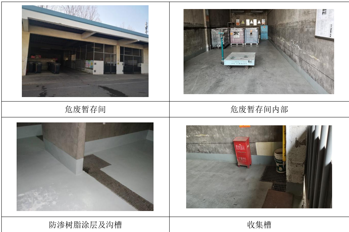
图 5-4 危废暂存间现状
