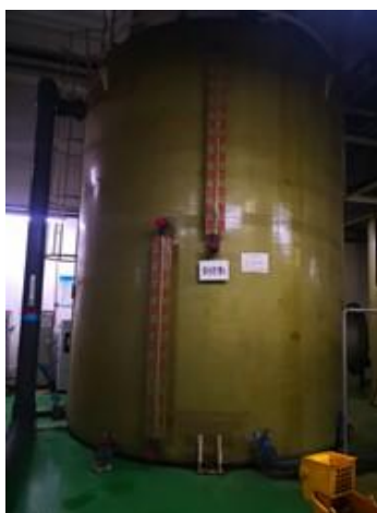
图 5-1 一厂污水处理站废水收集罐现状
