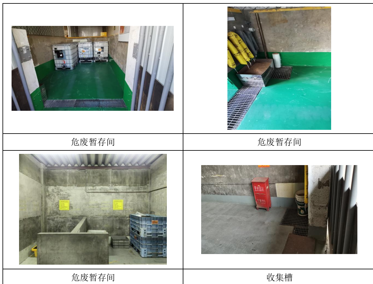
图 5-3 危废暂存间现状
