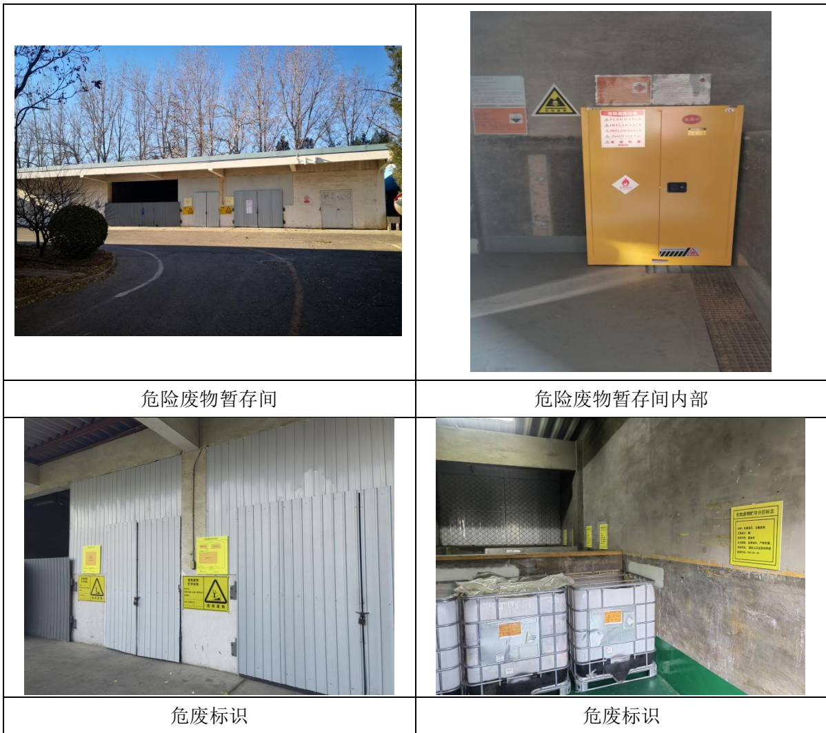
图 4-3 危险废物暂存间
