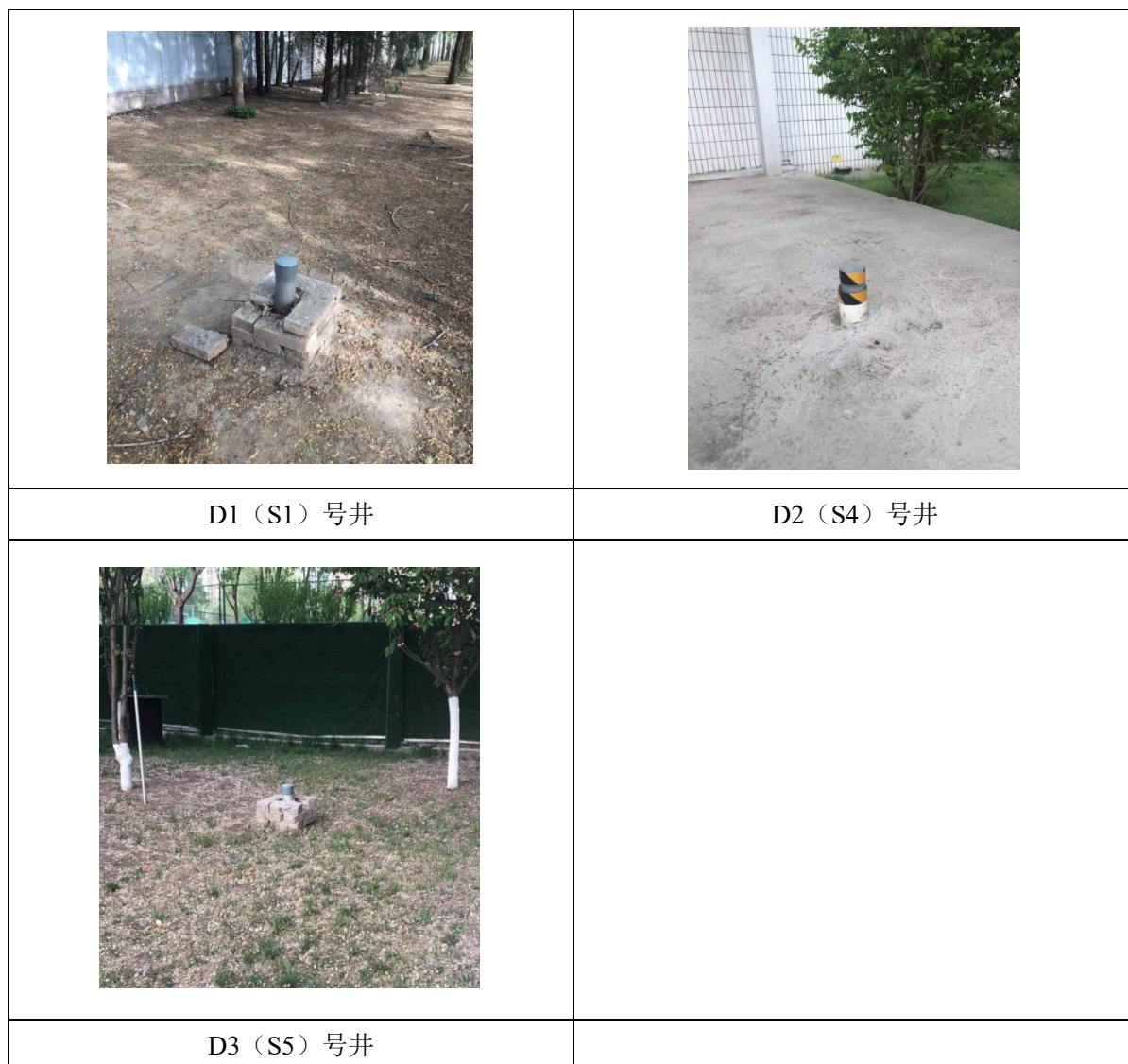
图 6-2 地下水监测井现状
