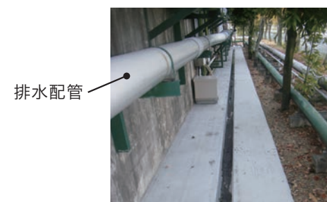
土壌部分のコンクリートによる舗装状況
