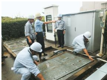
屋外現場監査の様子
