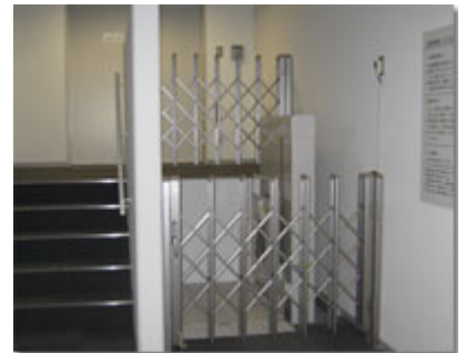
北伊丹事業所、社屋屋上へのリフト。
