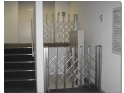
北伊丹事業所、社屋屋上へのリフト。
