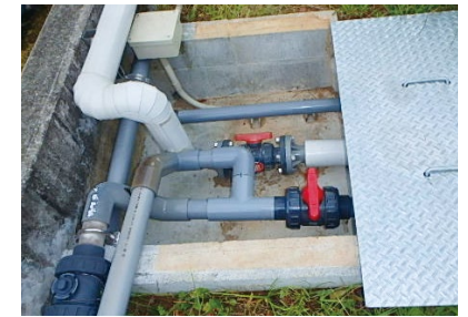
埋設配管の露出化工事状況 (高知工場)
