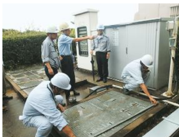
屋外現場監査の様子
