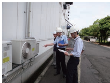
屋外現場監査の様子
