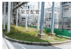
浸透防止対策施工前
